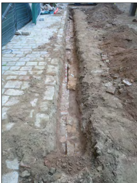
Vista de la fonamentació UE 133
