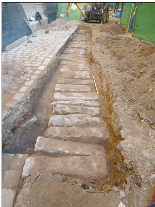
Coberta UE 106 de la claveguera UE 105
